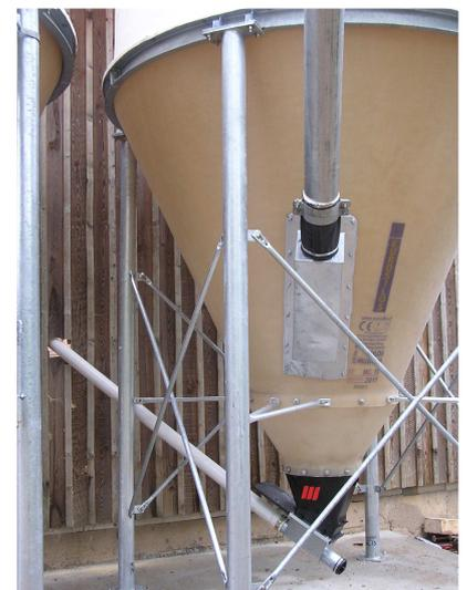
◀ **Gummi-Muffenflansch Ø150 mm mit Metall – Verstärkungsplatte und Rohrschelle 140 – 160 mm verzinkt**
